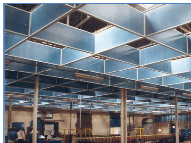
Installation de baffles suspendus
